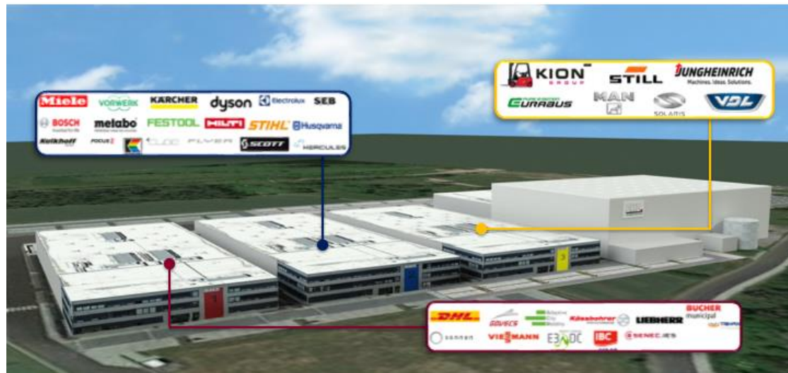
BMZ Group in Karlstein mit den aktuellen Erweiterungsbauten
